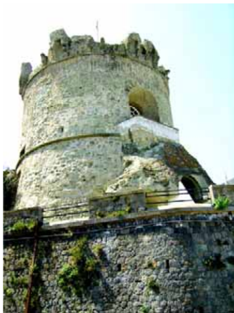
Fig. 10 - Green tuff Tower, Torrione, Forio
